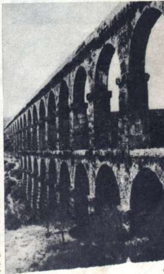
Acueducto de Tarragona, España. En las regiones donde escaseaba el agua, los romanos la proveían mediante canales; los desniveles eran salvados mediante acueductos elevados.
