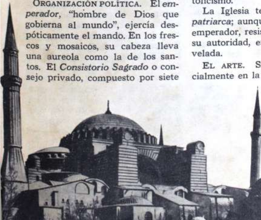
El exterior de santa Sofía, en Constantinopla. La enorme cúpula, de 31 m de diámetro, se sostenía sobre cuatro puntos de apoyo, sin necesidad de una pared circular de base.
