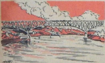
7. Puente ferroviario sobre el Magdalena, en Girardot. Mide 446 m. de largo.
