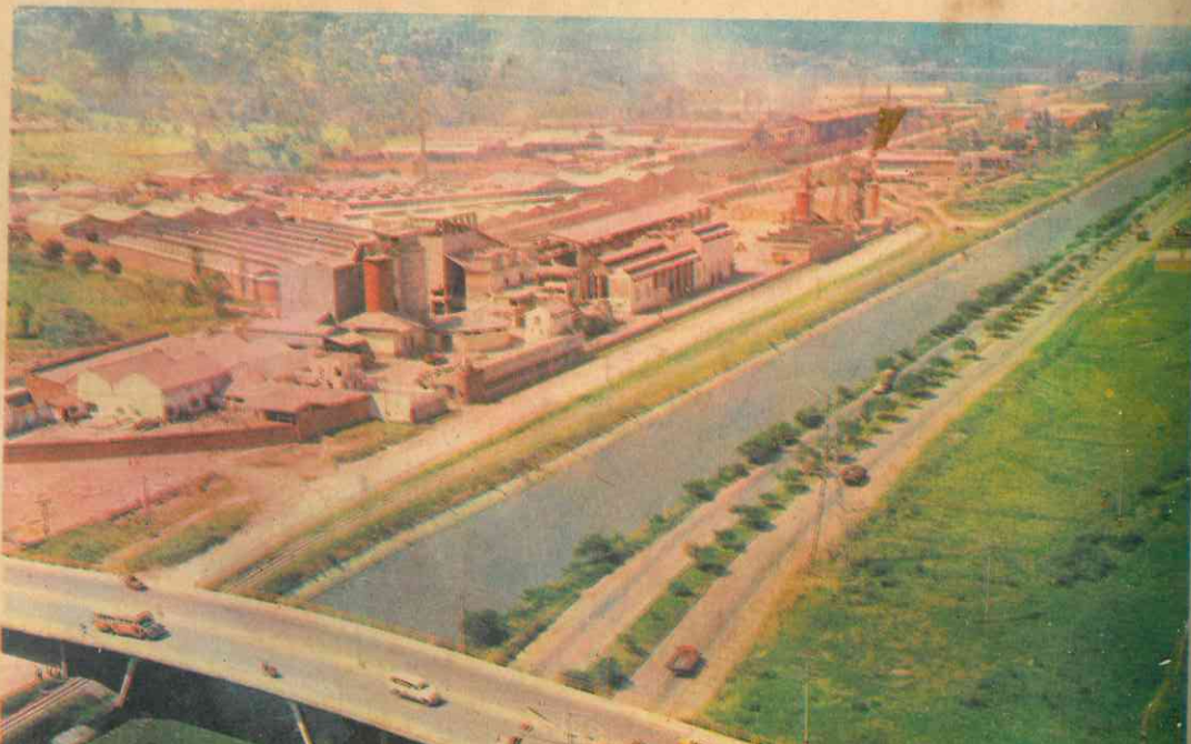
Fig. 51 - "Cemento Argos": Una fábrica que, con sus similares, concurre a la producción de 2.300.000 toneladas anuales de cemento colombiano.
