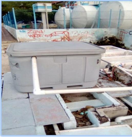
**Figura 8.** Tanque de sedimentación primaria de 760 litros
