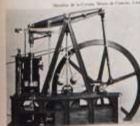
Módulo de la máquina de vapor inventada por James Watt. El vapor impulsa el pistón que se ve a la izquierda; el cual está conectado por un mecanismo especial a un brazo vertical que hace girar la rueda.
