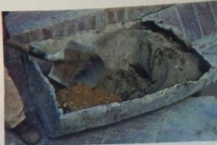
En la construcción,
