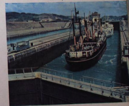
Los esclusas Miraflores bajan las naves desde Gaillard Cut hasta el nivel del Océano Pacífico.
