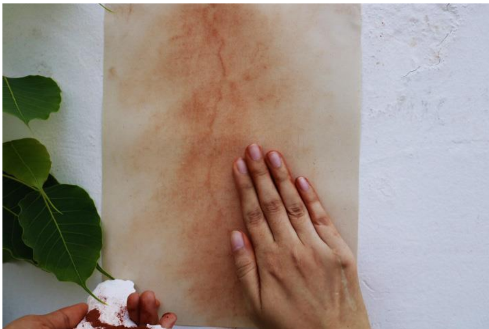
Gesto de frotar la grieta en las ruinas del Pedro Biava.
