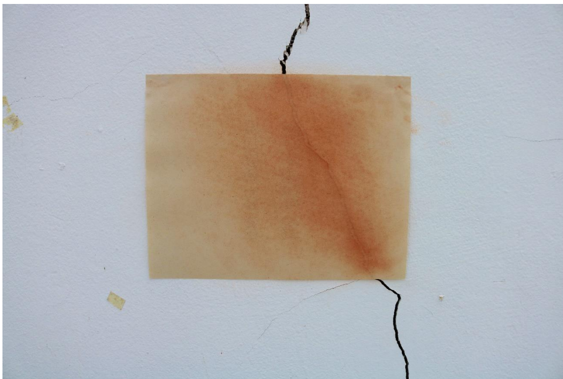
Gesto de frotar la grieta en las ruinas de la Galería la Escuela.
