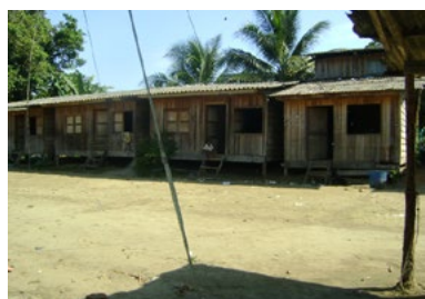
Sector residencial, una de las calles del corregimiento.
