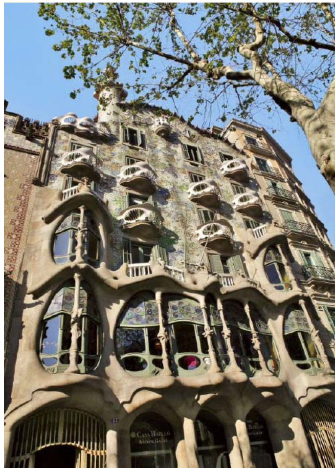
Figura 9. Casa Batlló, Arq. Antoni Gaudí, 1906
