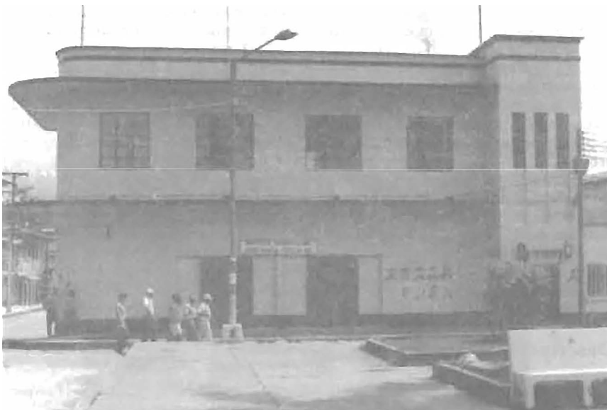
Figura 11. Fachada sobre el parque Centenario, Banco de la república, tomada en 1992
