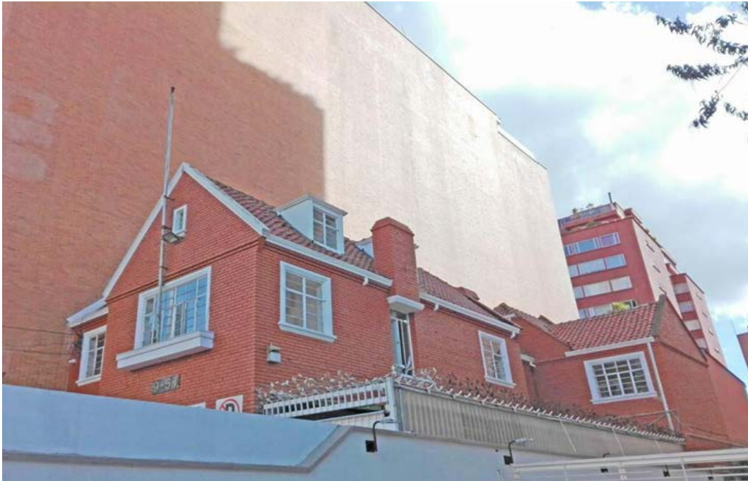
Figura 1. Casa estilo inglés con fachada en ladrillo a la vista.
