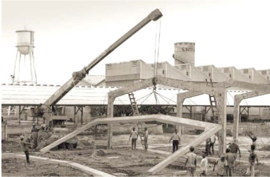
Figura 7. Montaje de estructura, marcos prefabricados de concreto en la planta de Eternit
