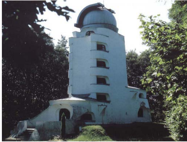
Figura 1. Torre Einstein (1919-1921) Postdam
