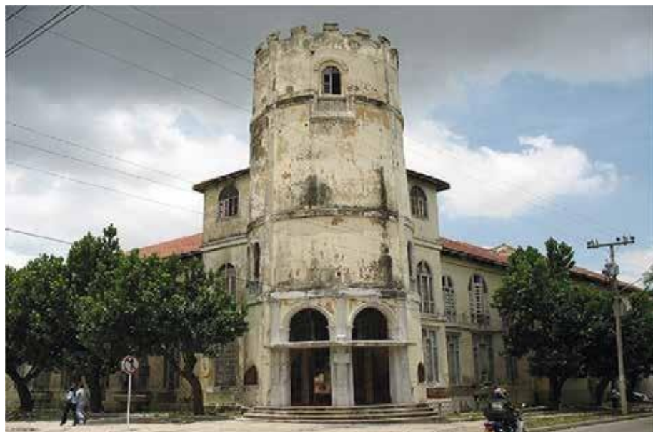
Sede del antiguo CODEBA (Carrera 41 Calle 51 esquina)
