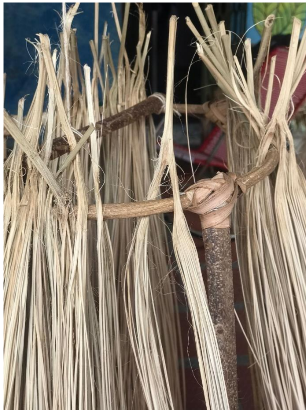
Figura 51 Organización de las palmas sobre la estructura
